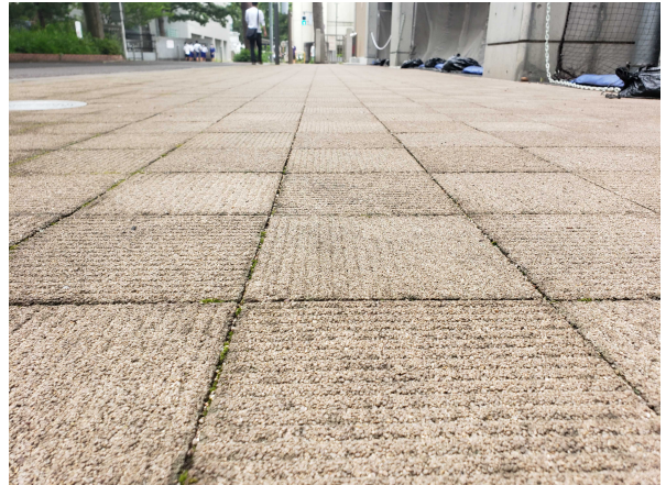
図4.4.9 平らなコンクリート
