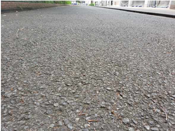
図4.4.8 荒いコンクリート
