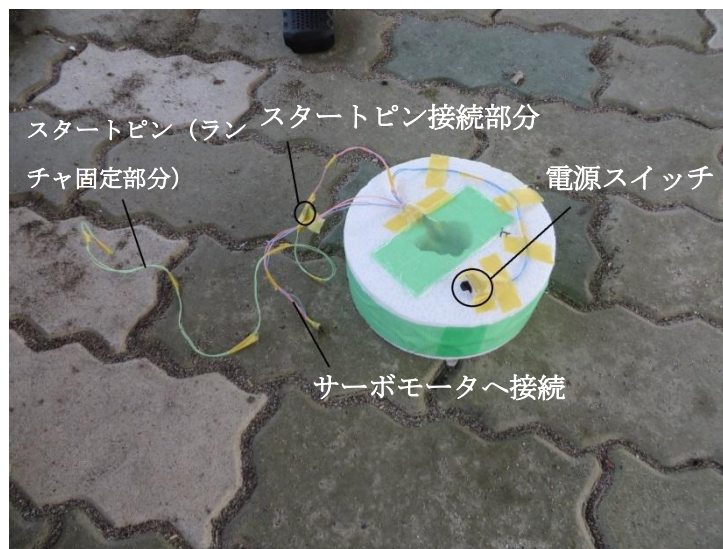
図 3.2.19 保護ケースに入れた分離回路
