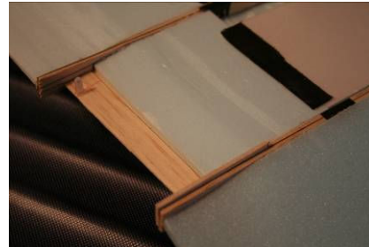
fig.8 破損部拡大画像
