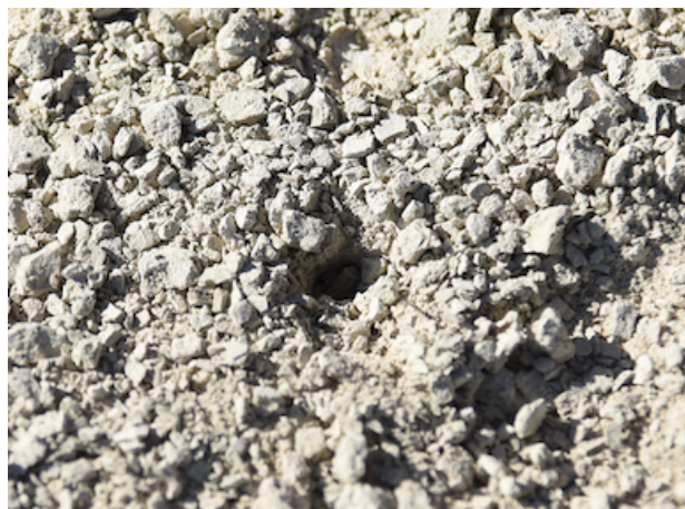
図 65 ドリル掘削によって生じた穴
